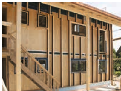
Stelaż z belek dwuteowych STEICO wall na masywnej ścianie drewnianej.
