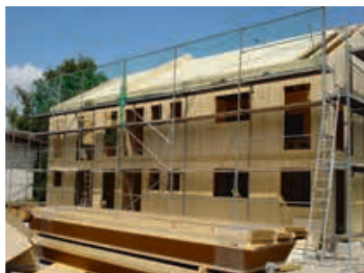
Belki dwuteowe STEICO joist przycięte wcześniej na żądany wymiar gotowe do montażu na dachu.
