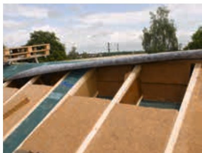
Termoizolacja dachu: belki dwuteowe STEICO joist z zaizolowanym środkiem wypełnione matami STEICO flex .
