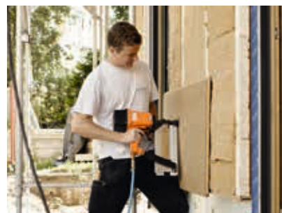
Stelaż wypełniony matami termoizolacyjnymi STEICO flex a następnie zamknięty płytą STEICO universal . Całość zostanie uwieńczona elewacją drewnianą.
